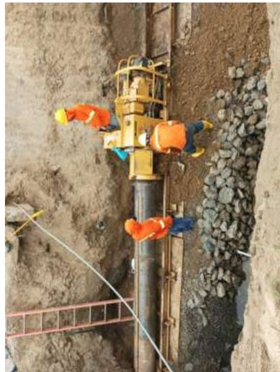
6.- Perforación con tubo ensanchado
