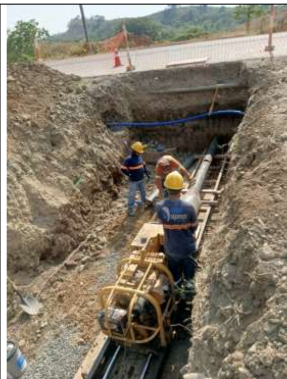
1.- Instalación del tubo guía.
