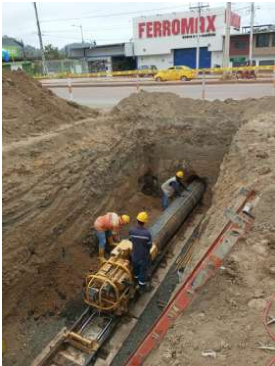
5.- Sujeción de tubo guía para nivel de
