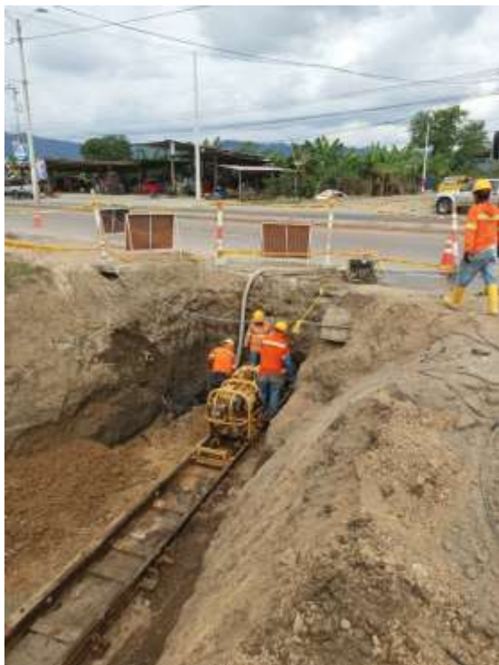
7.- Introducción del tubo camisa metálica
