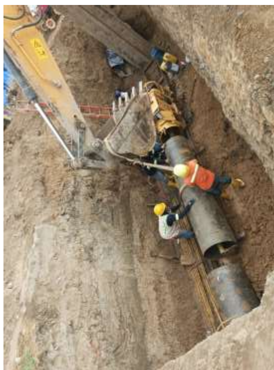
4.- Colocación de segmento de tornillo barrenador.
