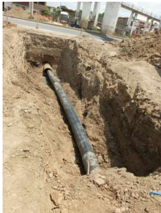
8.- Introducción del tubo PEAD dentro del tubo camisa de perforación metálica
