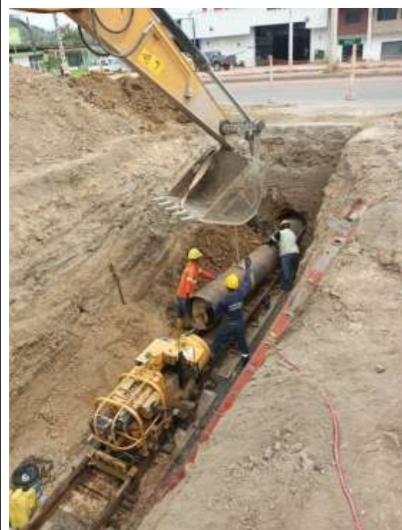
3.- Instalación del tubo ensanchado
