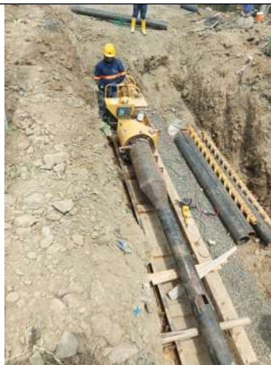
2.- Perforación con el tubo guía.
