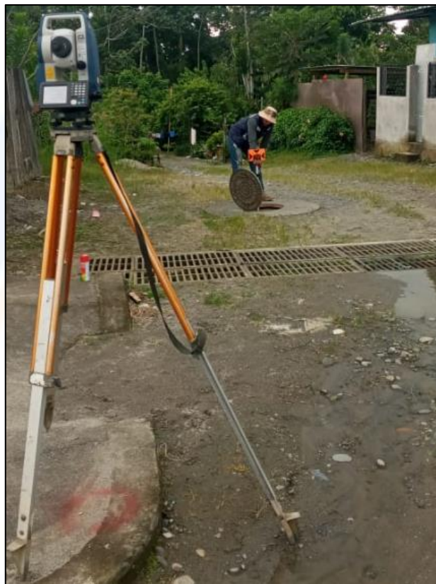
Figura 4. Red existente alcantarillado pluvial – sector Transervis (Pozos y rejillas)
