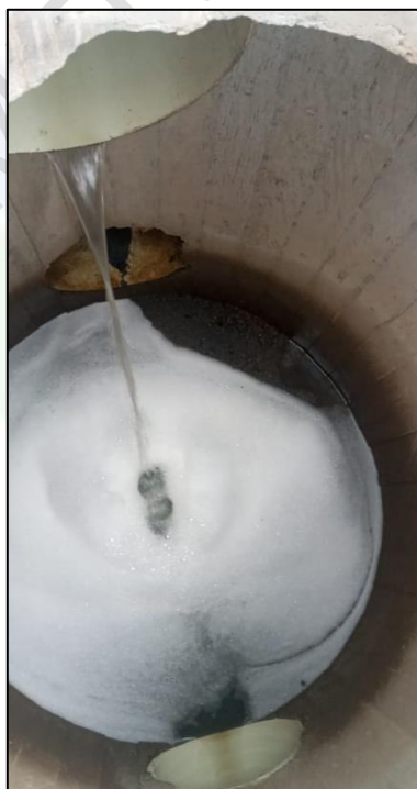
Figura 5. Red existente alcantarillado pluvial – sector Transervis (Sección interna pozo)
