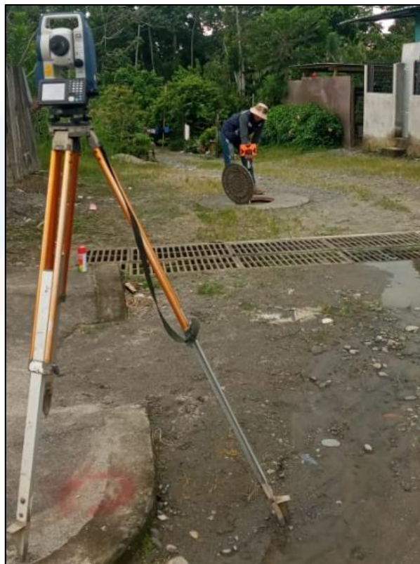
Figura 5. Red existente alcantarillado pluvial – sector Transervis (Pozos y rejillas)
