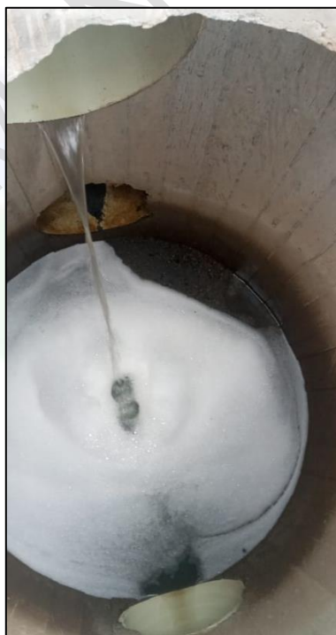
Figura 6. Red existente alcantarillado pluvial – sector Transervis (Sección interna pozo)
