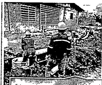
Colocación de un sumidero con tubería de 250 mm.
