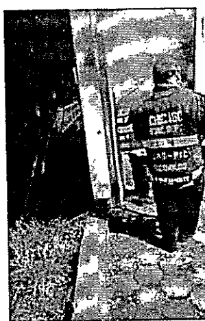
Pérdida del tablero de control y fuerza por incendio en la planta de captación Rosa Zárate – 07 de mayo de 2024
